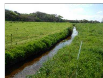
Cours d'eau recalibré sur le Ploudalmézeau
