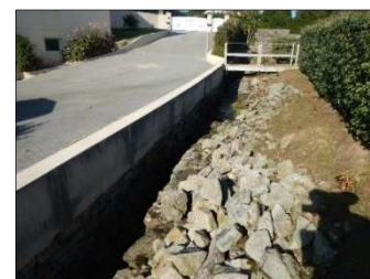
Protections de berge sur l'Aber Wrac'h.
